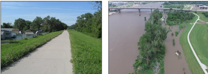
Los diques disminuyen la frecuencia de inundaciones en las propiedades vecinas. Foto de la izquierda: sección típica de un dique. Foto de la derecha: Dique que retiene el agua de la inundación de 2019.
